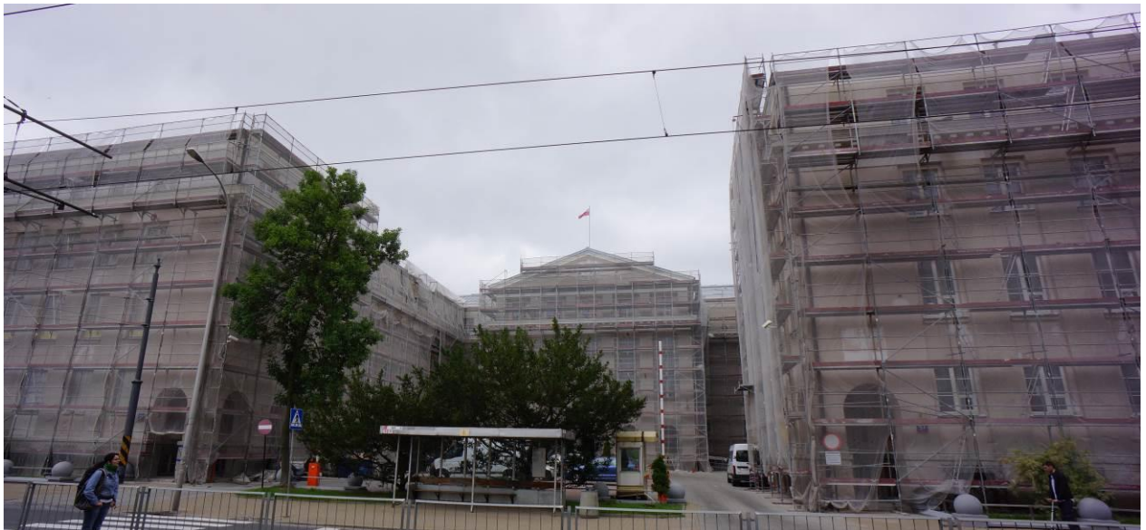
Remont elewacji NIK – czerwiec 2014
