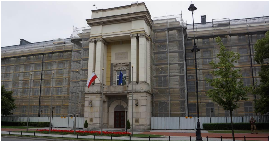
Remont elewacji Kancelarii Premiera – czerwiec 2014
