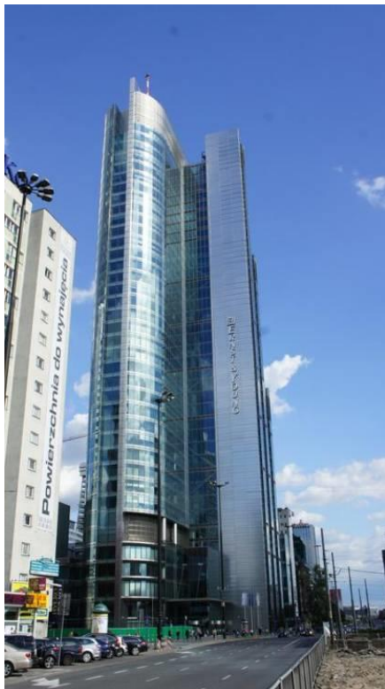
Wieżowiec „Rondo 1”, Warszawa – garaże podziemne
